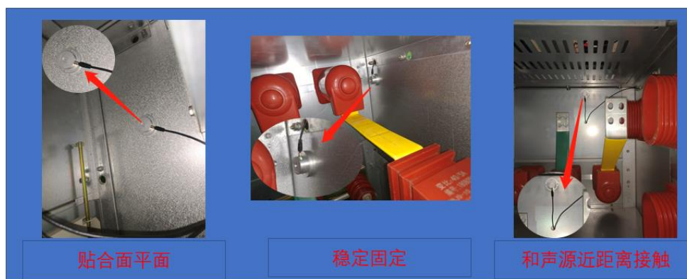
图 1.探头安装实例图
